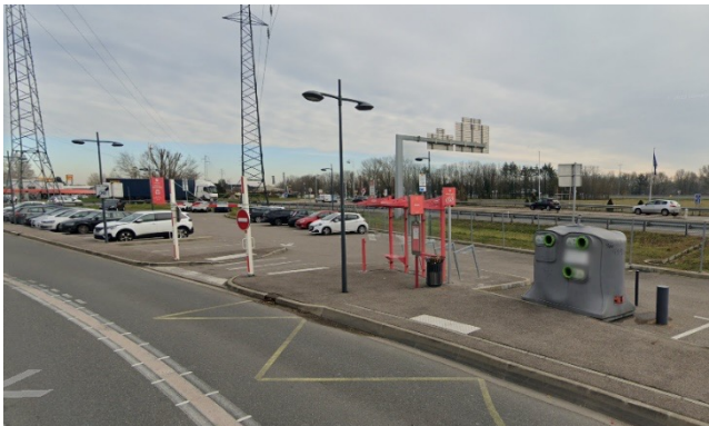
Figure 6 Aire de covoiturage de Beynost – CCMP – sortie 5 A42
