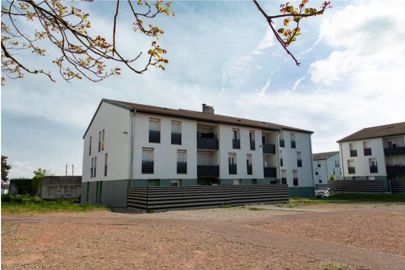
Figure 35 : Riante Plaine - La Verpillière - Réhabilitation de 209 logements sociaux
