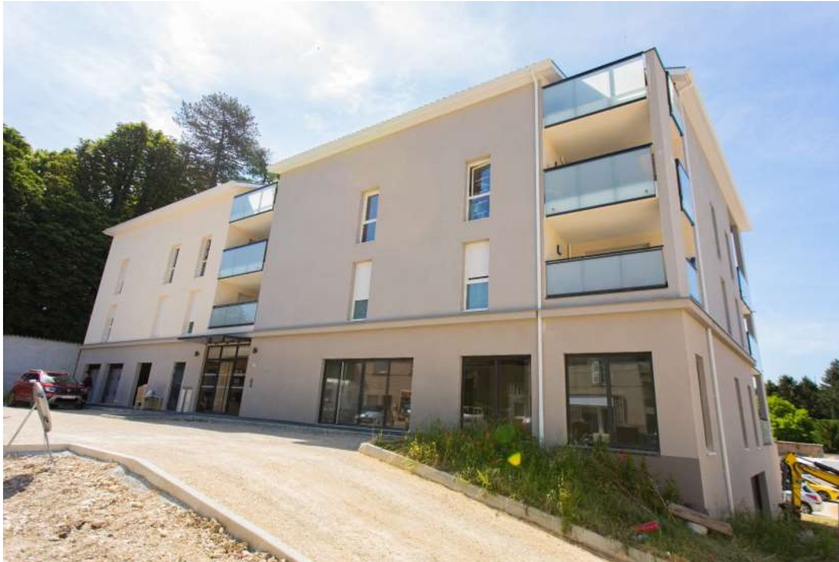
Figure 19 : Ruy-Montceau - les Aurélys - Construction de 34 logements après démolition d'une boulangerie industrielle
