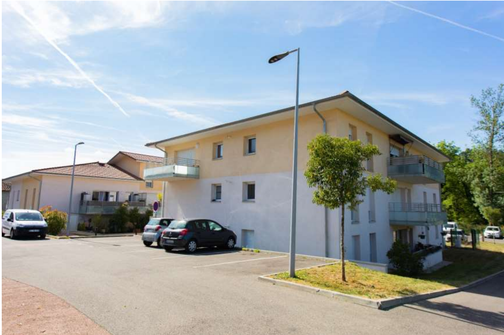
Figure 23 : Saint-Savin - La Robinière – Construction de 25 logements locatifs sociaux
