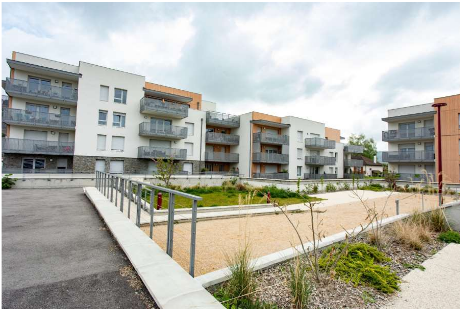
Figure 27 : Ruy-Montceau - La plaine du milieu – Construction de 138 logements dont 85 logements sociaux
