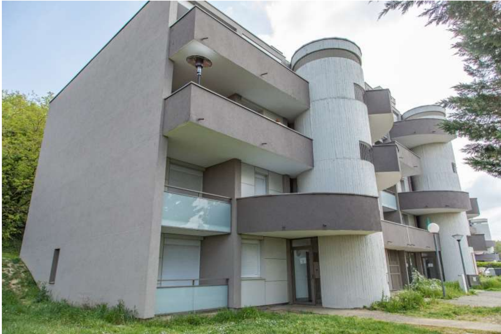
Figure 10 : Villefontaine - Muissiat (réhabilitation du parc social)
