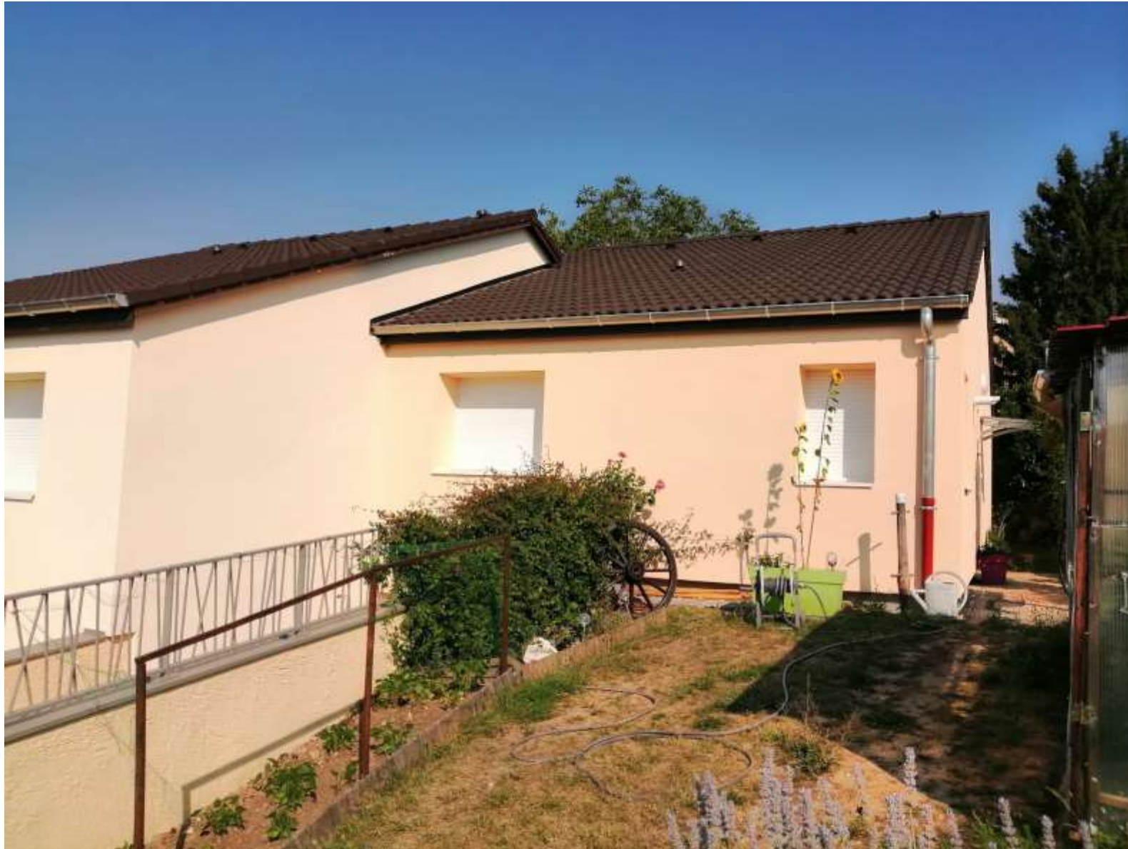
Figure 4 : Eclose Badinières : Plein Sud- Réhabilitation du parc social
