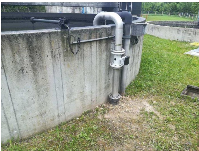
Remplacement de la conduite d'alimentation des eaux brutes et installation du débitmètre électromagnétique
