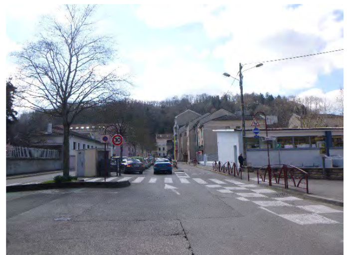
Quai bus avenue Maréchal
