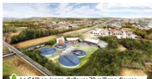
A La CAPI envisage d'allouer 70 millions d'euros sur cinq ans pour optimiser la gestion des eaux sur son territoire. Ici, la future station d'épuration de Bourgoin-Jallieu.
