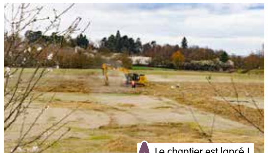
Le chantier est lancé !
