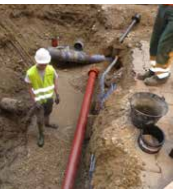
1 km de réseaux d'eau potable va être renouvelé, et 1,7 km de nouveaux réseaux sera créé.
