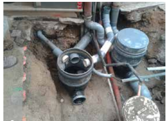
À gauche, les eaux usées, à droite, les eaux pluviales.
