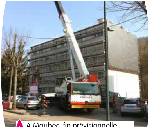
À Maubec, fin prévisionnelle des travaux en décembre 2015
