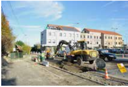
Rue des silos à Bourgoin-Jallieu : création de trottoirs, sécurisation des cheminements piétons, réfection de chaussée (115 000 euros TTC).
