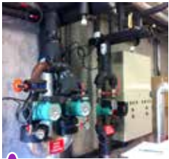
Bien régler la chaufferie : source d'économies !
