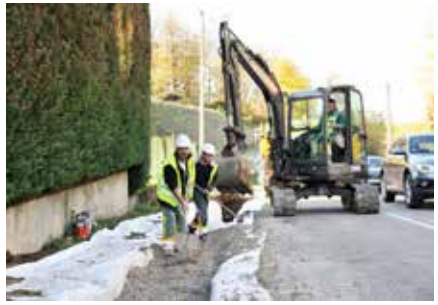
Route de Chatonnay à Ruy-Montceau : création de trottoirs, réalisation d'aménagements de sécurité, gestion des eaux pluviales, rénovation de l'éclairage public (1150 000 euros TTC).
