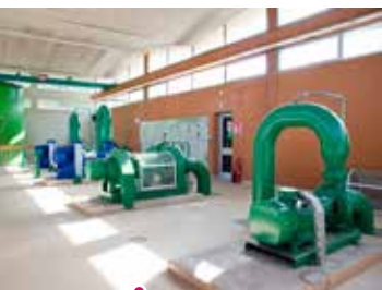
La salle des pompes du captage du Vernay (vers Bourgoin-Jallieu)
