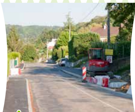
▲ Création de trottoirs à la montée des Épaluds à Domarin
