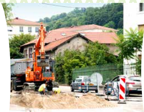
▲ Mise en séparatif des réseaux d'assainissement route de Saint-Jean à Bourgoin-Jallieu
