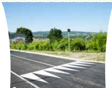
▲ Réhabilitation de la chaussée rue de Lissieu à L'Isle d'Abeau
