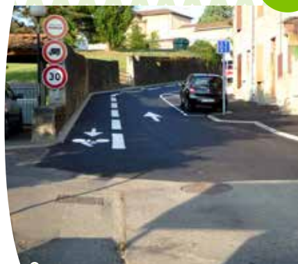
▲ Rue des silos à Bourgoin-Jallieu
