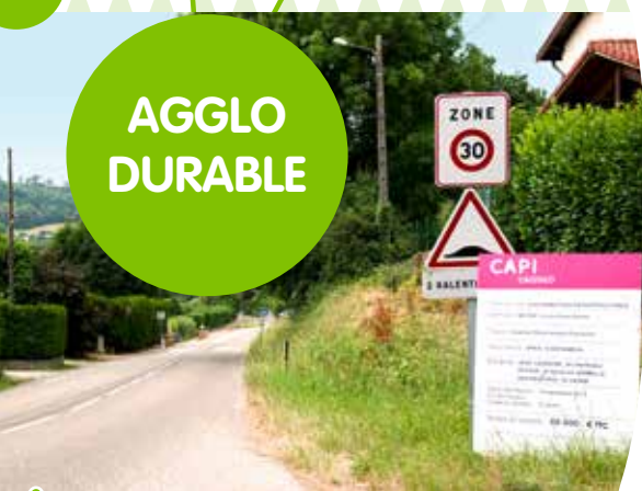
▲ Création d'un cheminement pour piétons à Meyrié
