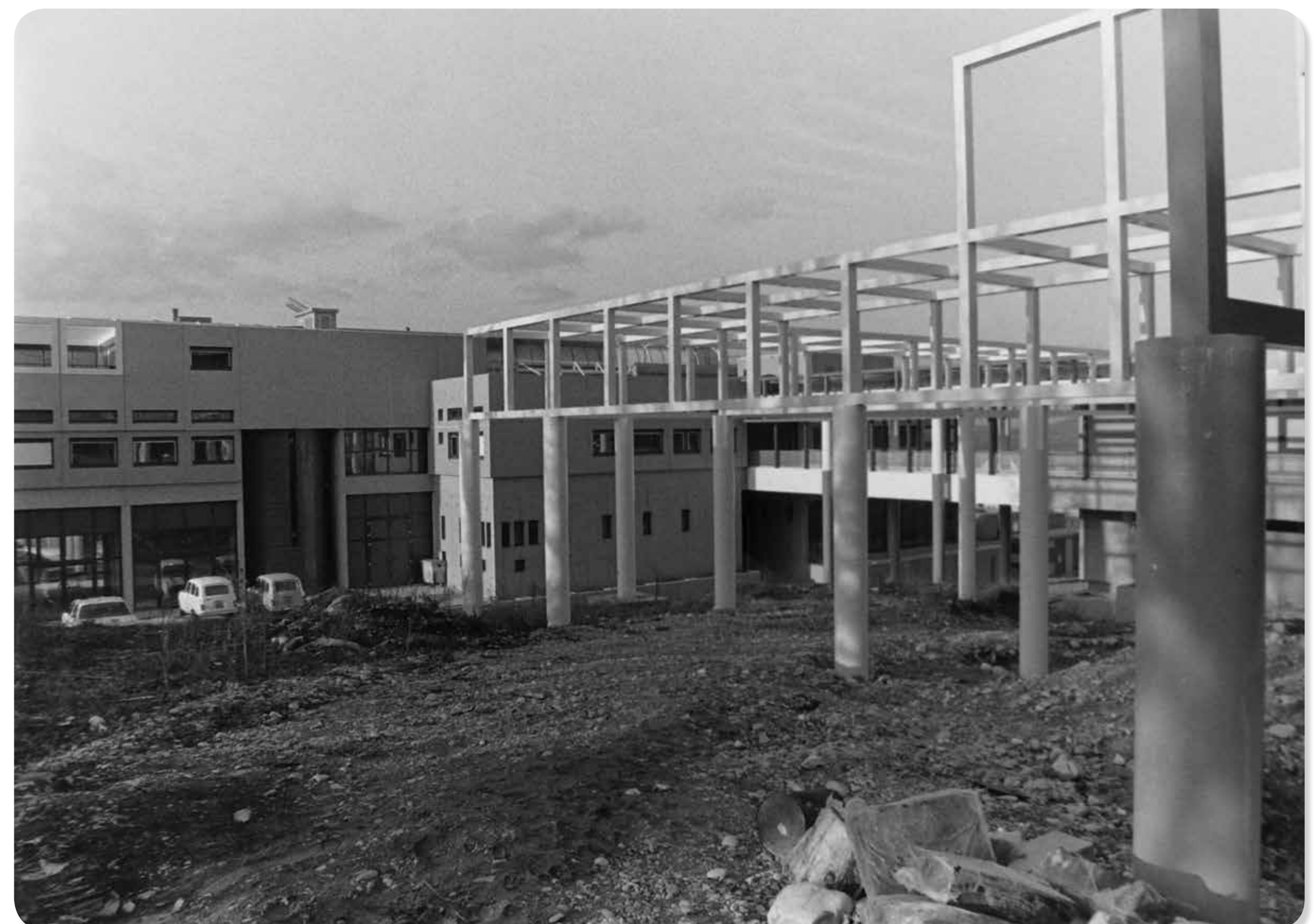
➤ Vue sur la passerelle
