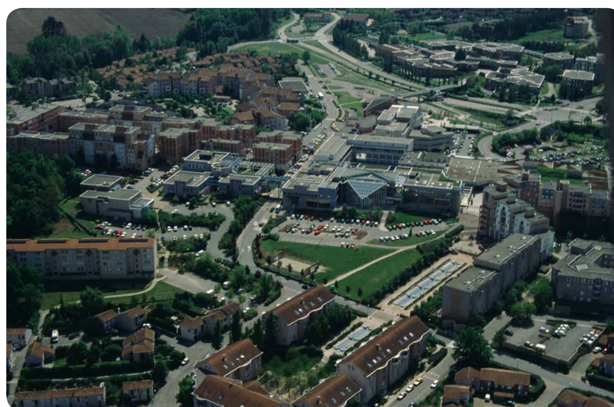
➤ Vue côté parking n°1
