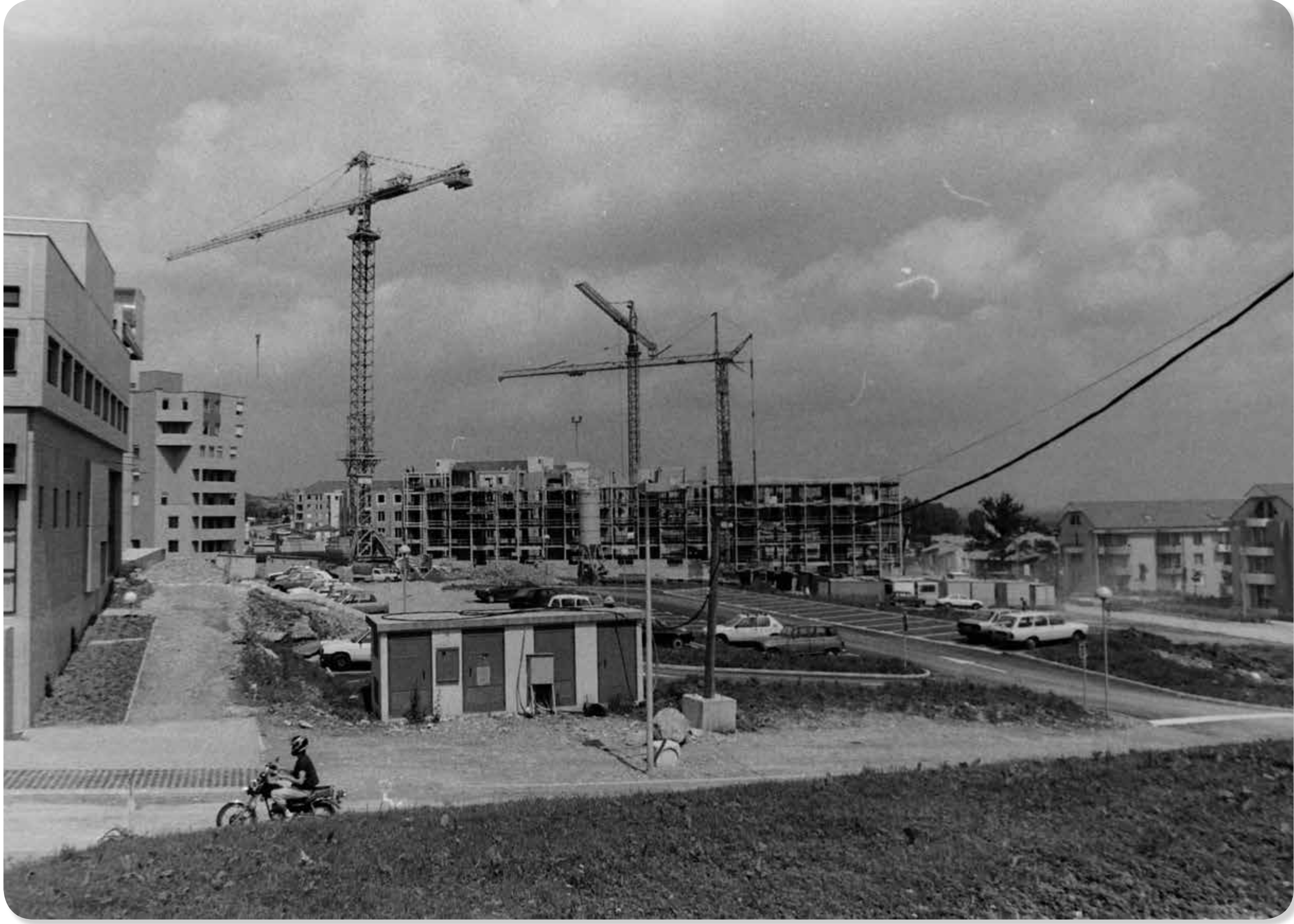
➤ Vue du Parking
