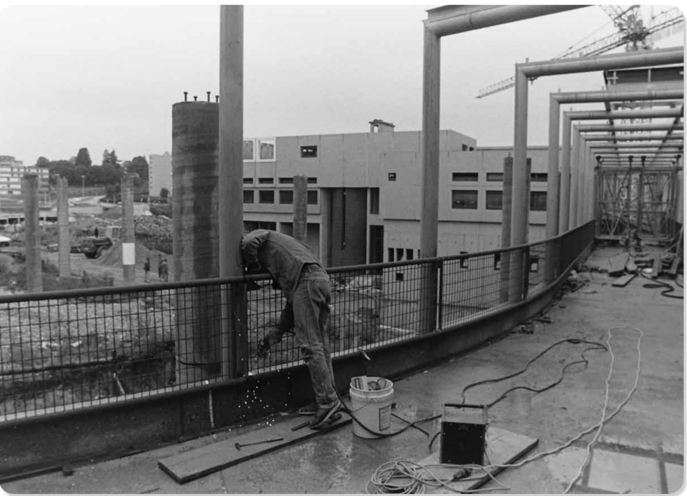
➤ Construction de la passerelle
