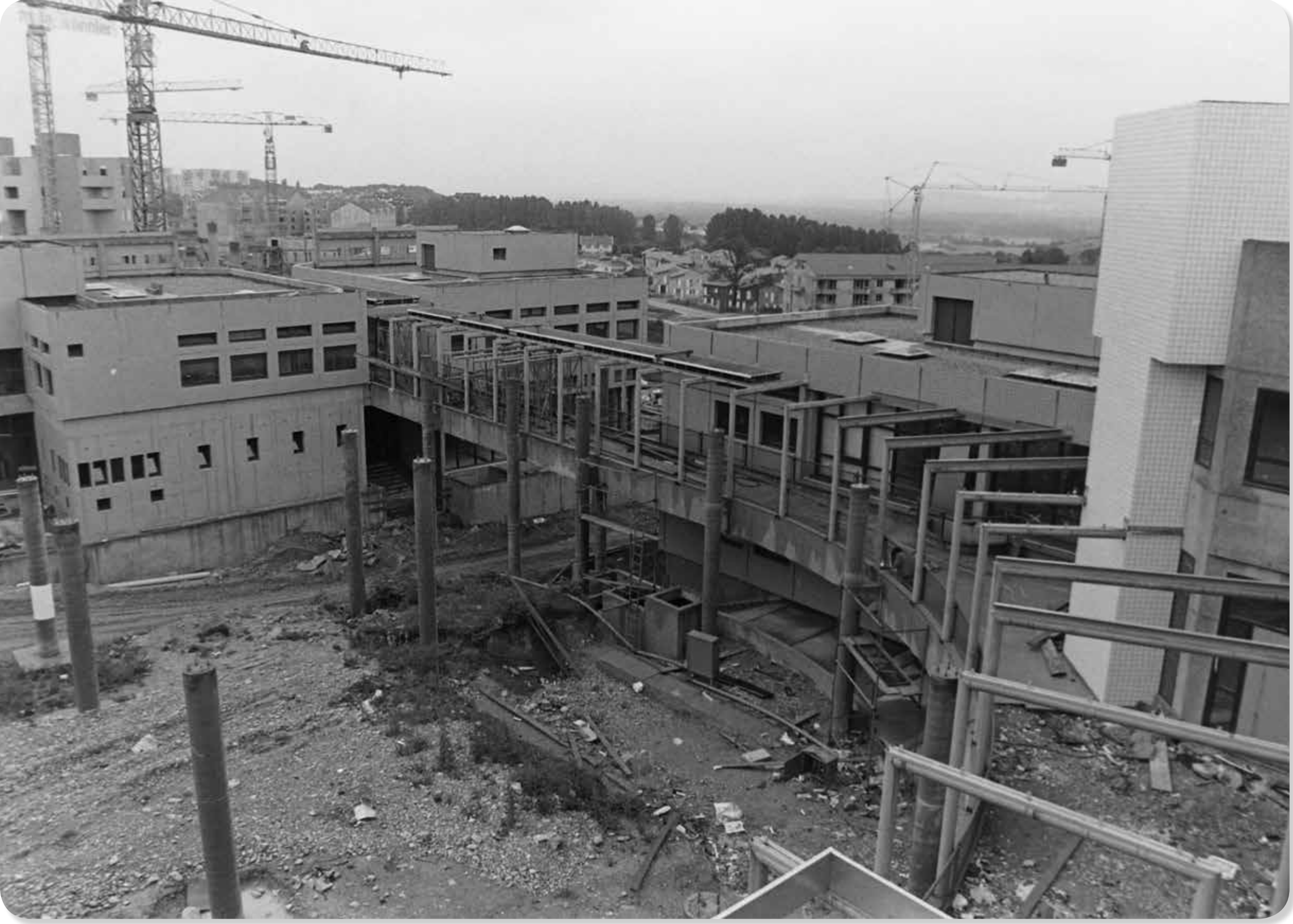
➤ Construction de la passerelle, vue de dessus
