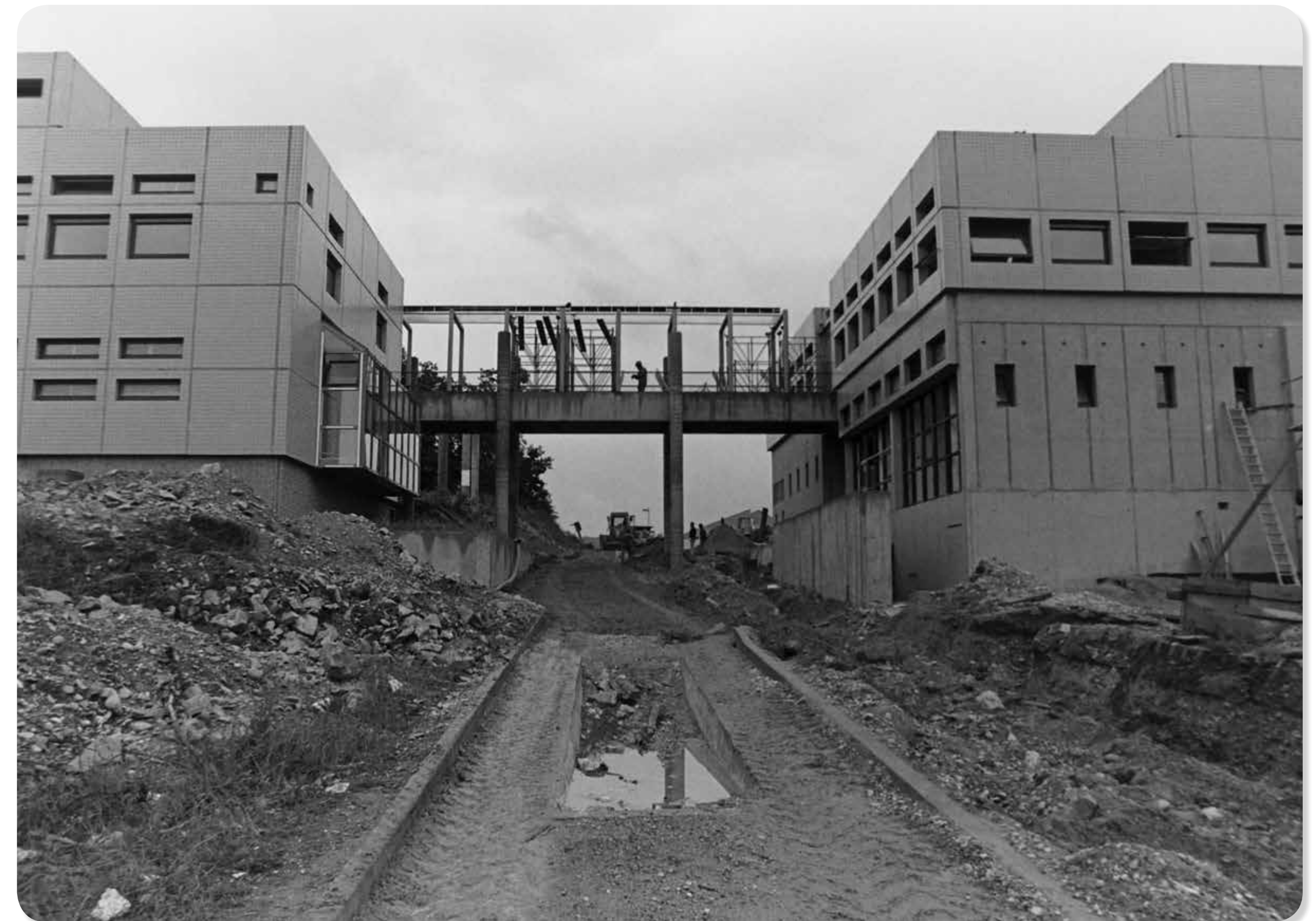
➤ Construction de la passerelle, vue de dessous
