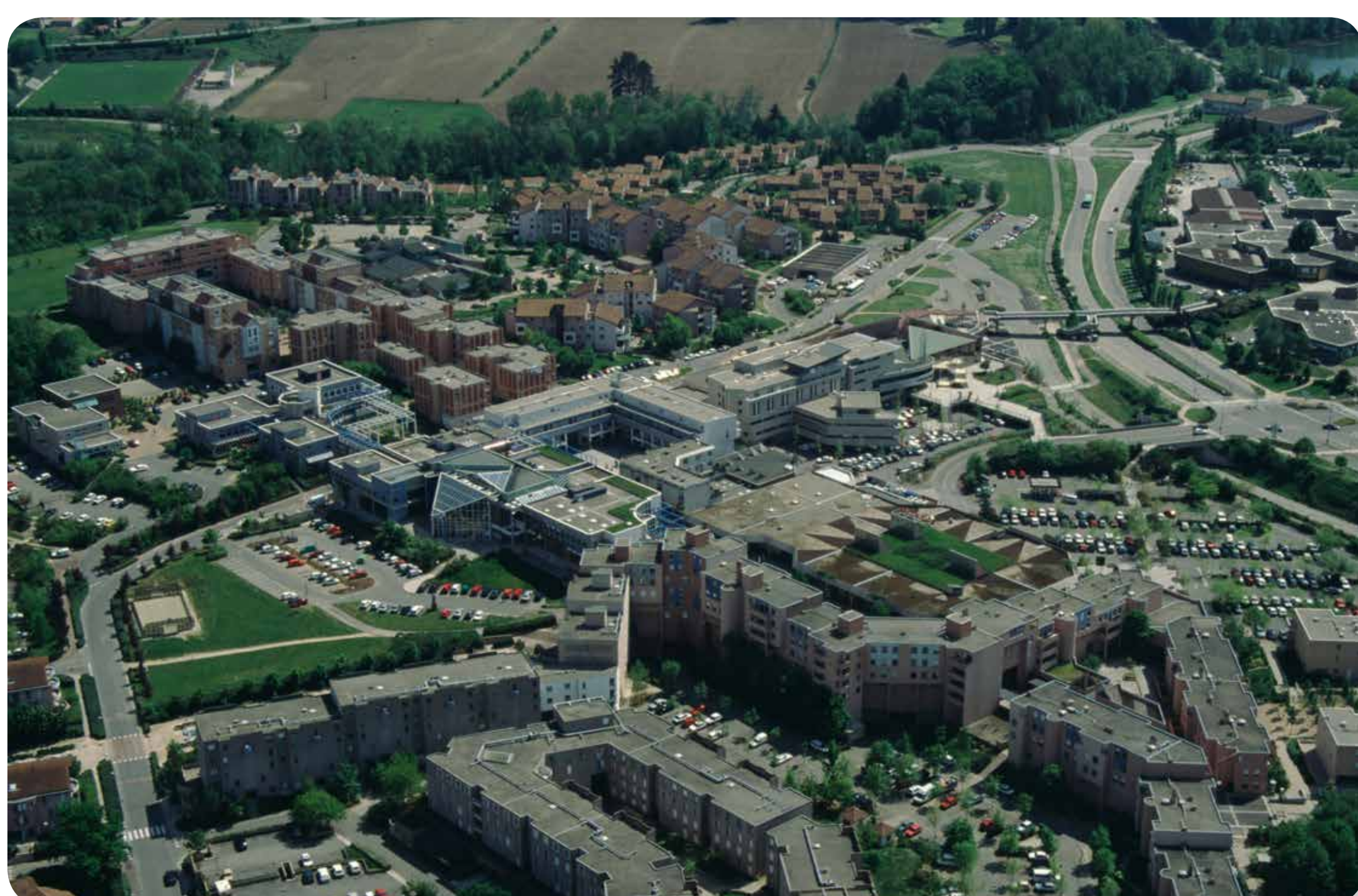
➤ Vue côté parking n°2
