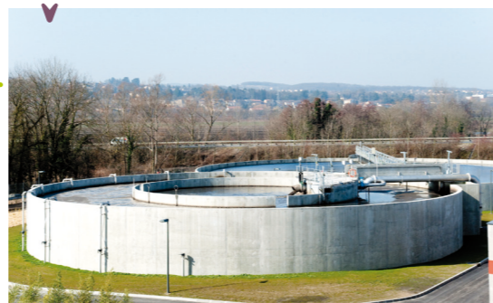
STATION D'ÉPURATION - BOURGOIN-JALLIEU
