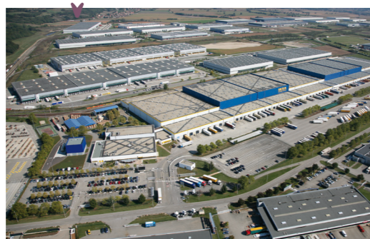
ZAC DE CHESNES - SAINT-QUENTIN FALLAVIER
